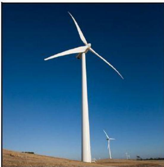
Le facteur déterminant pour le choix du modèle d'éolienne à mettre en place a été le vent, présentant localement des vitesses moyennes modérées. Le choix d'ABO WIND s'est donc porté sur des machines VESTAS V90, éoliennes à rendement élevé pour sites localisés à l'intérieur des terres. De plus, ce type de pales, d'une longueur de 44 mètres, permettent d'être acheminées jusqu'au site malgré une accessibilité restreinte.
