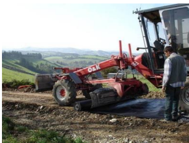
Pose du géotextile
