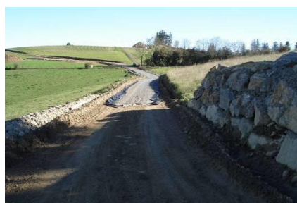
Mise en place du gravier
