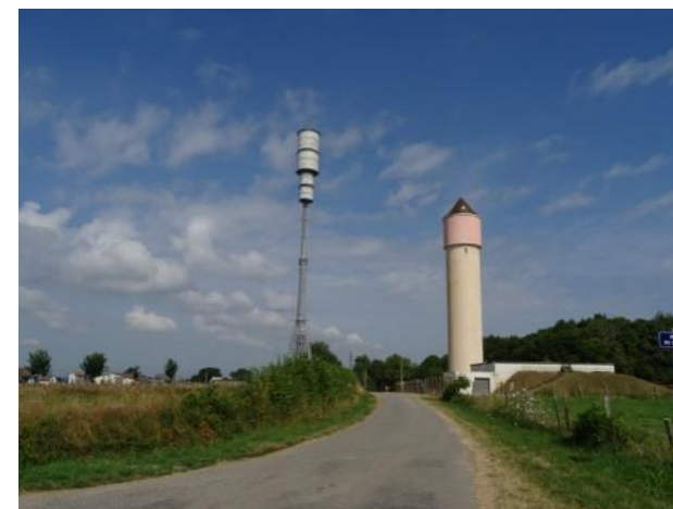
Antenne et château d'eau à Saint-Plantaire : des éléments ponctuels qui dénotent du reste de l'urbanisation du bourg.
