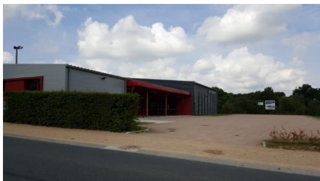
Photographie de la salle multisports à Orsennes – juillet 2016
